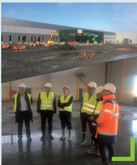
Visite de chantier de la nouvelle usine Tangy matériaux à Plouédern.
