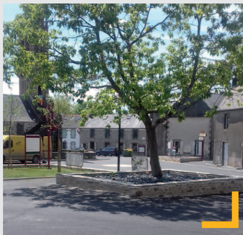
Aménagement du bourg de Saint Eloy.
