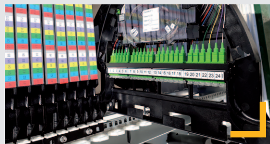
Installation des armoires pour le déploiement du très haut débit.
