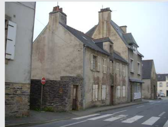
Mur sous emplacement réservé au PLU Angle rue de la Libération et rue de la Liberté
