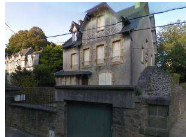
VILLA - 8, Boulevard de la Gare
