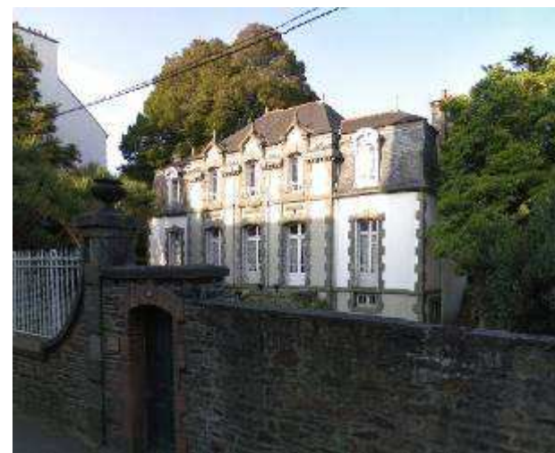
VILLA - 10, Boulevard de la Gare
