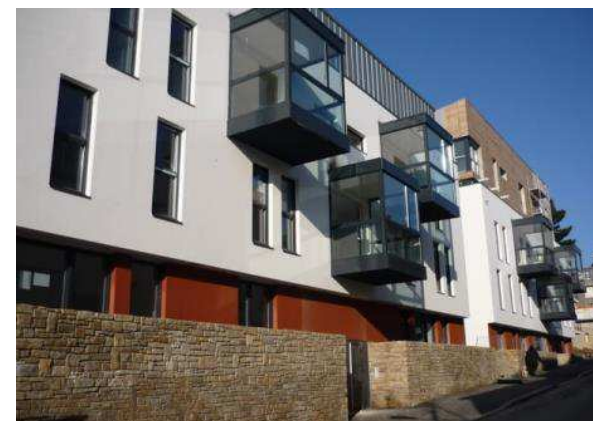
Exemple d'une volumétrie complexe avec des volumes en saillie à l'alignement sur la voie et un mur en pierre qui assure la continuité bâti.
