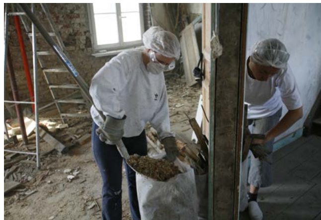
Travaux de rénovation d'une maison
