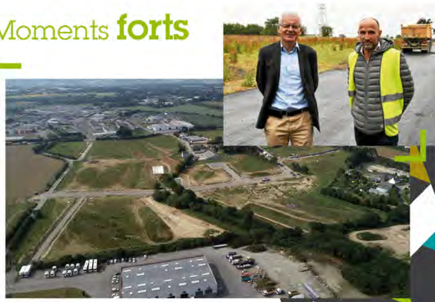
Zone St Alar en cours aménagement
