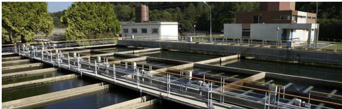
Figure 70 : vue de la station de Pont Ar Bled
