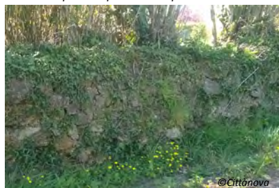
Muret de pierres présents à proximité du site
