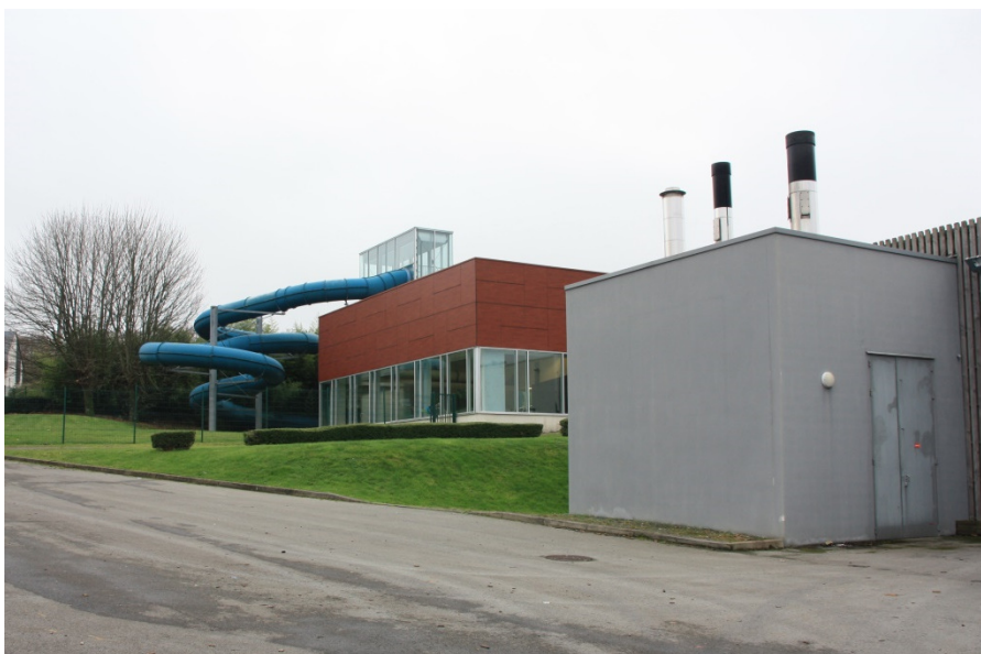
Figure 18 : La chaufferie bois de Landerneau sur le site du centre aquatique Aqualorn, Décembre 2021 (source : Intermezzo)
