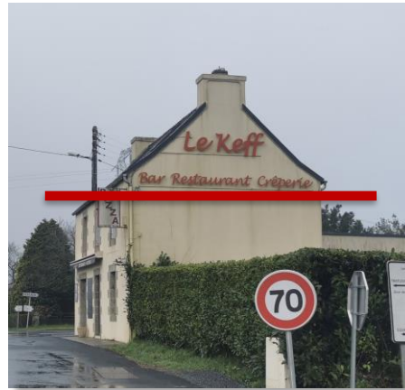
Dépasse de la limite d'égout du toit
