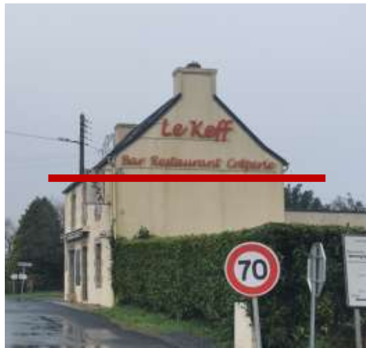
Dépassement de la limite d'égout du toit
