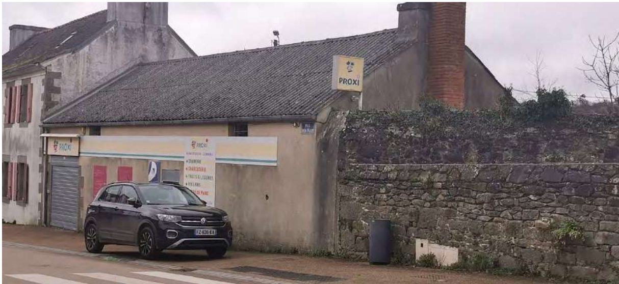
Enseignes installées sans vrai rapport avec la composition de la façade dans le PNRA – Hôpital-Camfrout
