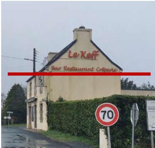
Dépassement de la limite d'égout du toit
