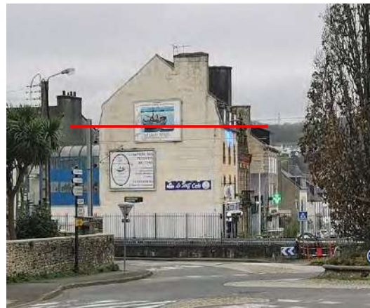
Publicité murale qui dépasse la limite d'égout du toit
