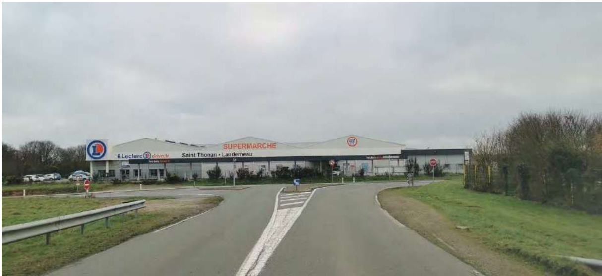
Enseignes sur façade dépassant la ligne d'égout du toit – Saint-Thonan
