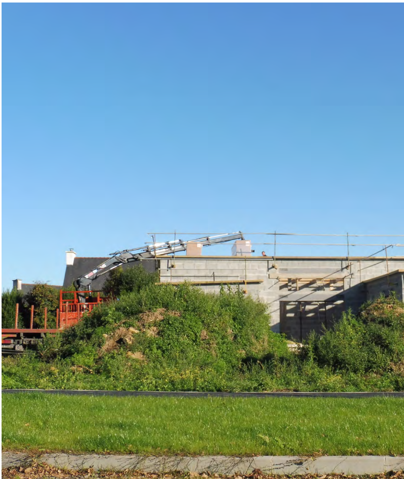
Maison en construction à Landerneau (c) Cittànova
