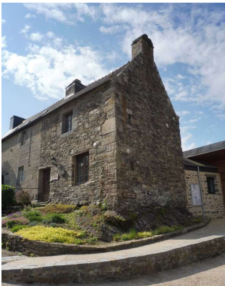
◀ Maison de bourg, Hôpital-Camfrout Grès et roche affleurante
